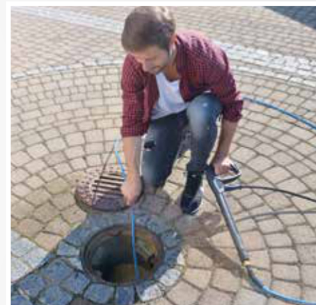
Afb. Wasborstel dwars - lange uitvoering
